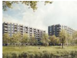
Sihl Terrassen Zurich
